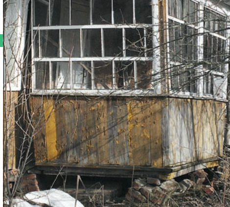
На пластичных грунтах столбики со временем могут просто рассыпаться
