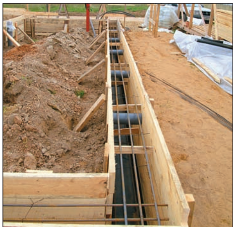
При устройстве фундамента нельзя экономить на арматуре
