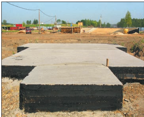
Монолитная плита - хороший вариант для небольшого дома на сложных грунтах при любой глубине залегания грунтовых вод
