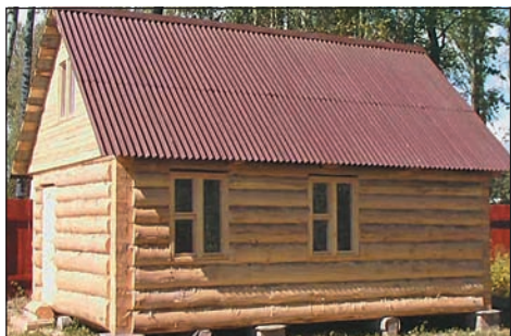
Традиционный фундамент под дачные домики - блоки ФБС или столбики из кирпича - дешево, но не надежно
