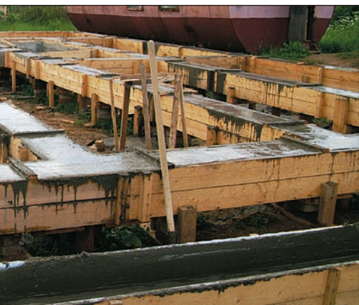
Монолитная плита - хороший вариант для небольшого дома на сложных грунтах при любой глубине залегания грунтовых вод
